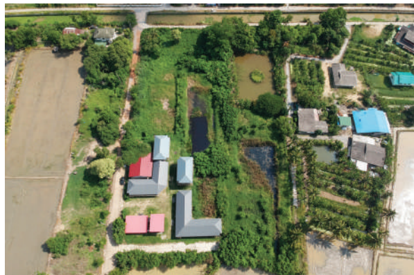
▲ ที่ดินโครงการบ้านพิพิธภัณฑ ๒ ต.จัวราย อ.นครชัยศรี จ.นครปฐม เมื่อแรกซื้อ พ.ศ.๒๕๕๑ ถ่ายลงไปทางทิศใต้ 694-A-010-ส11ตค2551
